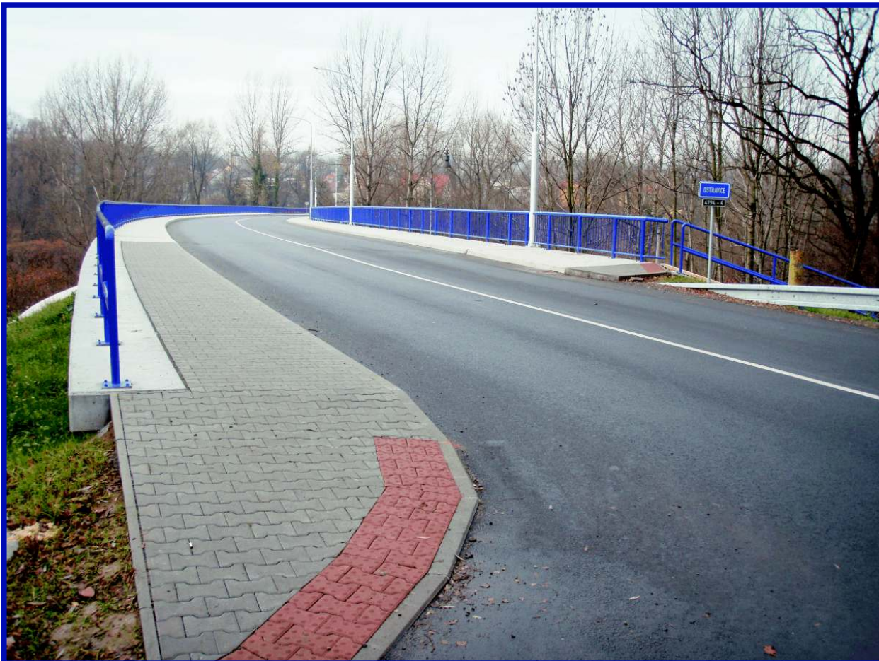
IMG_1100 Pohled na sanaci mostní konstrukce
